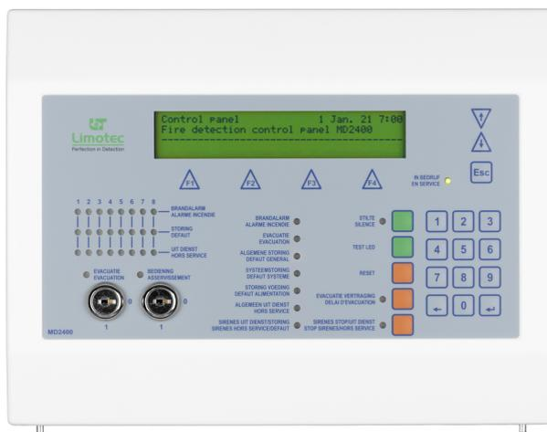
**La console de commande MD2400 est incluse dans le certificat BOSEC B-9072-FD-964 EN54-13 du système de détection incendie MD2400 & MD2400L.**
