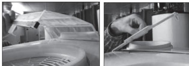
Effectuer le nettoyage du filtre avec de l'eau et du savon neutre. Assurez-vous que le terminal externe du conduit d'échappement d'air et le conduit lui-même ne soient pas obstrués ou détériorés. Assurez-vous que le tuyau d'échappement des condensats est libre de tout obstacle. Vérifiez la propreté des grilles et des conduits. Après chaque démontage de bride il est conseillé de remplacer le joint.
